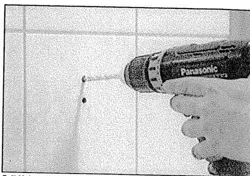
[ Bild 2.] 7 mm borrar endast genom kakel (använd kakelbollar)
