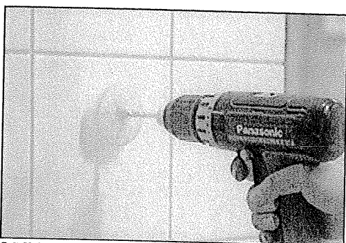
[ Bild 1.] Märk ut önskat läge på detaljen (lämpligast mitt i kakelplattan) förborra genom väggens alla material med 5.5mm borrar typ Wedevåg hårdmetall.
